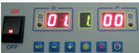
3) L'affichage montre les températures instantanées: température de chaudière (gauche) et température du ballon d'ECS (droite) . Si la sonde de l'eau sanitaire n'est pas branchée l'affichage de droite montre le message LO.
