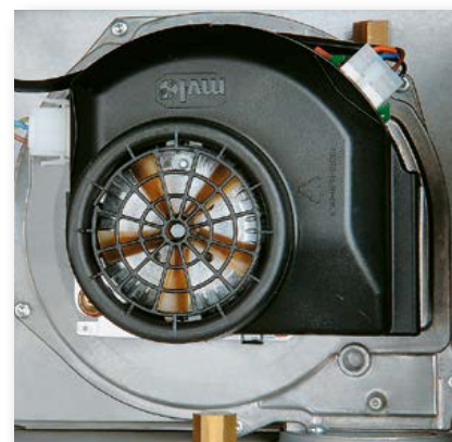
Combustione sempre controllata premix pneumatico e ventilatore modulante
