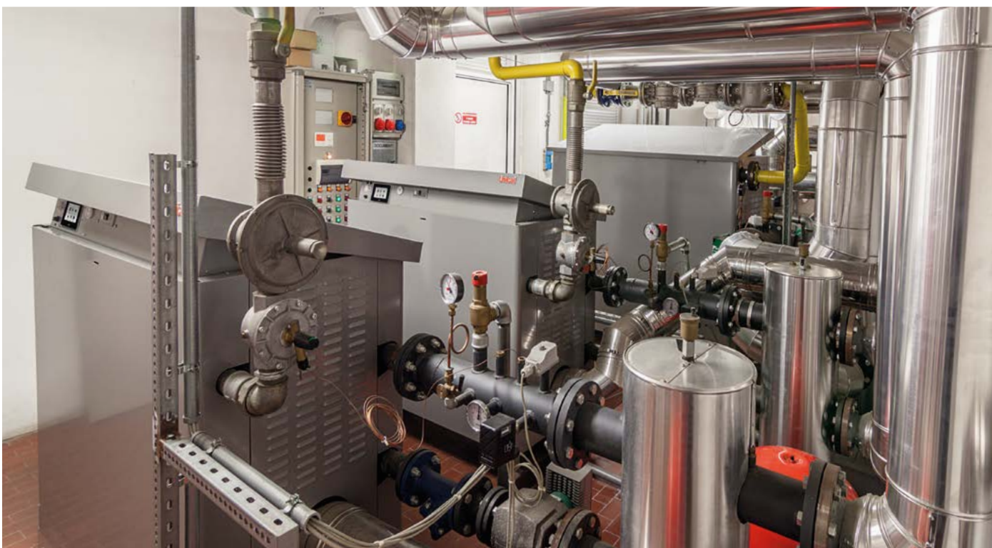
INSTALLAZIONE IN CENTRALE TERMICA
