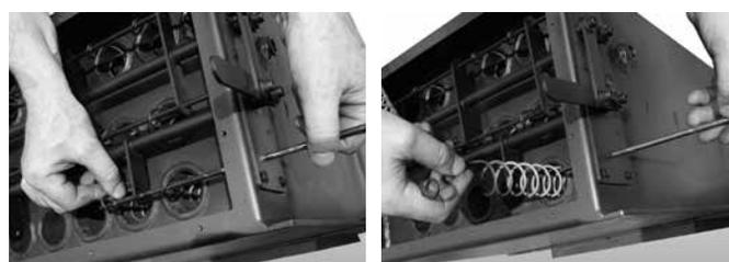
Ora la sezione superiore allo scambiatore di calore è sgombra da qualsiasi ingombro in modo da permettere una perfetta pulizia.
