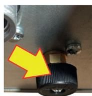
Ripristinare il corretto valore di pressione agendo sul rubinetto di carico caldaia (per un funzionamento ottimale il valore della pressione deve essere compreso fra 0,8 e 1 bar). Al raggiungimento del valore di pressione minimo (0,6 bar), il funzionamento della caldaia viene ripristinato.
